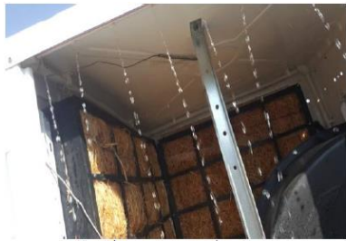
ب) محل نصب سنسور دمای سقف
